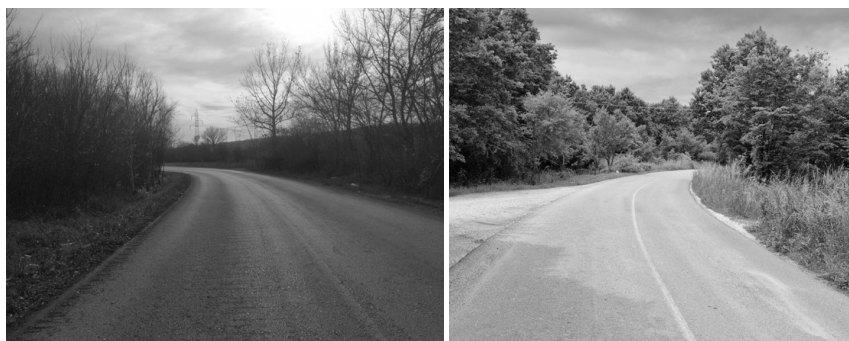
Slika 11: Nedostatak signalizacije za najavljanje i obeležavanje krivina
