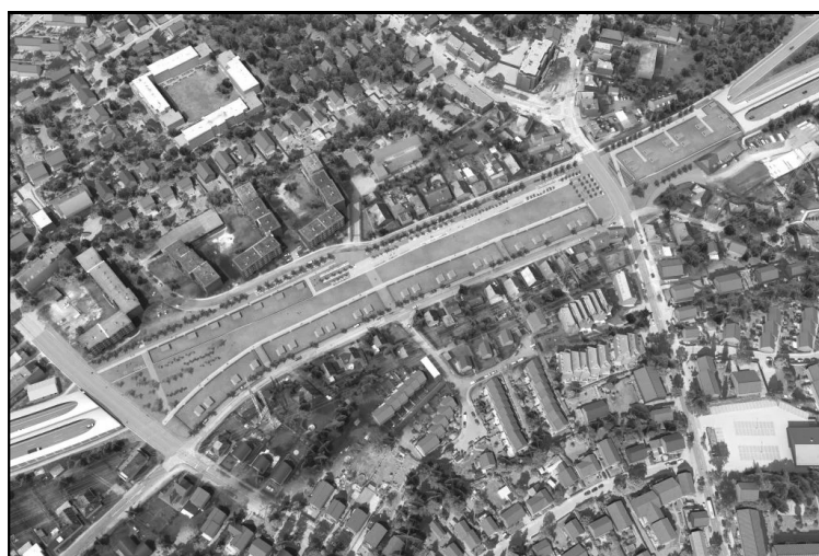
Slika 7. Nemačka, Autobahn, Hamburg, Altona tunel – Pogled „odozgo” [4]
