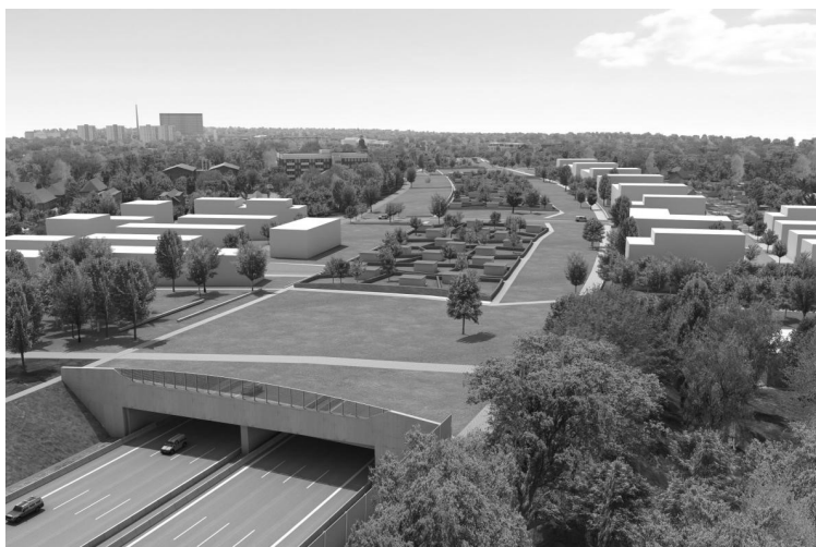
Slika 6. Nemačka, Autobahn, Hamburg – polaganje autoputa u tunelsku konstrukciju u cilju smanjenja negativnih uticaja na urbanizovano područje, Altona tunel [4]
