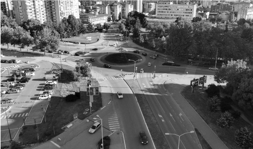
Slika 1: Izgled analizirane raskrsnice
