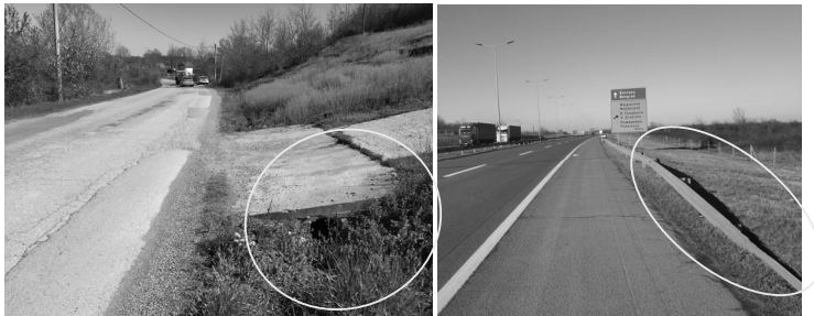
Slika 12: Pasivno nebezbedne prepreke pored puta
