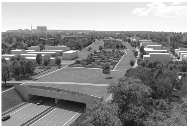
Slika 6. Nemačka, Autobahn, Hamburg – polaganje autoputa u tunelsku konstrukciju u cilju smanjenja negativnih uticaja na urbanizovano područje, Altona tunel [4]
