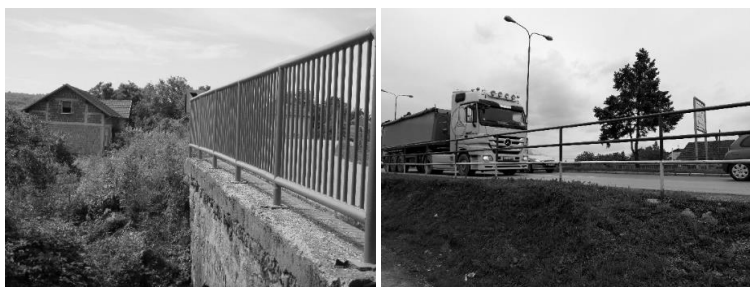
Slika 13: Primeri neadekvatnih ograda za zadržavanje vozila
