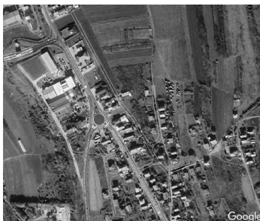
Slika 18. Izgradnja sabirnih saobraćajnica
