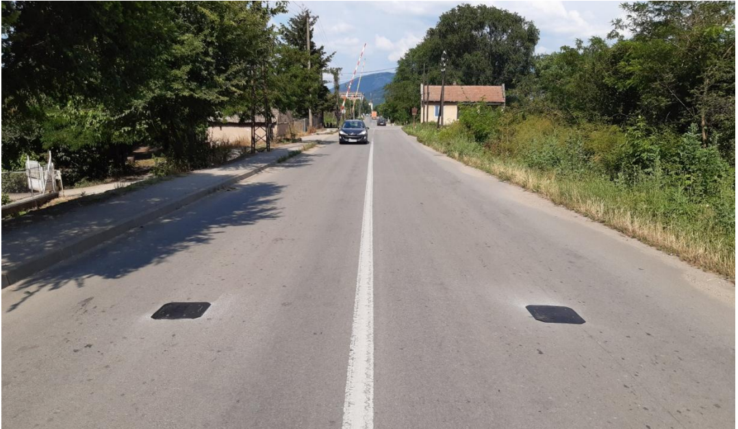
Slika 2: Mobilni brojači „MH Corbin“ NC300 postavljeni u dvosmernoj ulici u naselju
