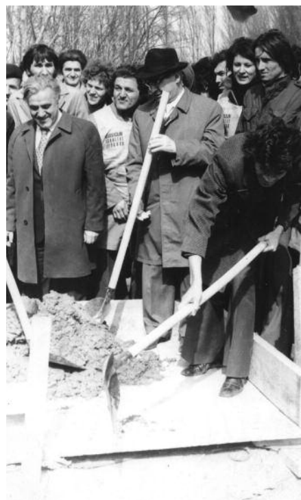
Постављање камена темеља зграде Саобраћајног факултета, 14. 3. 1975 6
